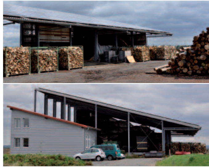
Auf dem Biomassehof in Beuchte mangelt es weder an Lagerfläche für die Holzbrennstoffe, noch an Dachfläche für Photovoltaik-Module.
