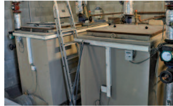
Die beiden Hackschnitzel-Kessel heizen seit dem Winter 2008.
